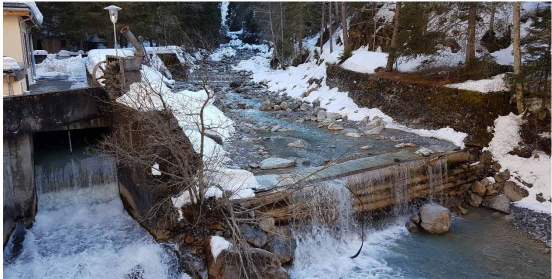
Abbildung 1: Bestehende Schwellen sowie Triebwasserkanal der Energia Engiadina SA
